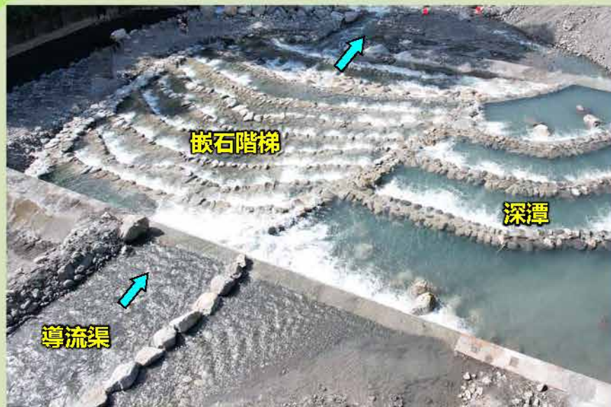
中央嵌石階梯及右側深潭蓄水測試
