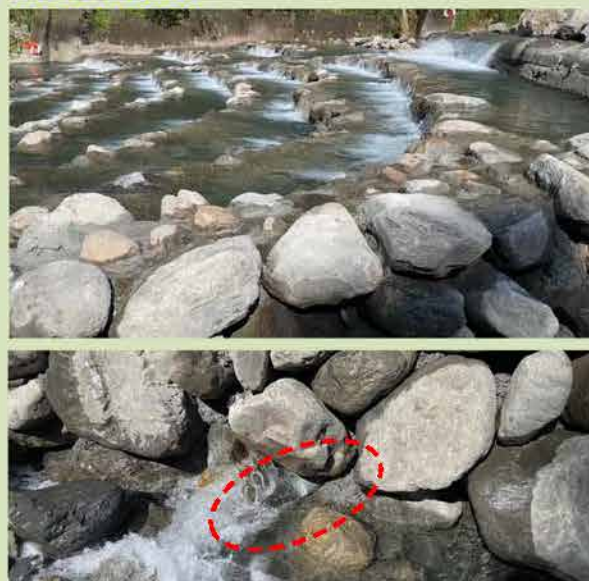
縱向隔牆聯通管通水測試
