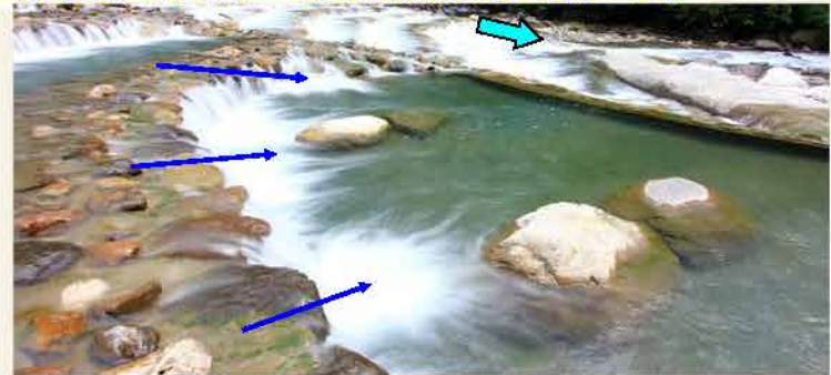
深潭區設置導流石引道流心，減少對既有側牆沖刷 26
