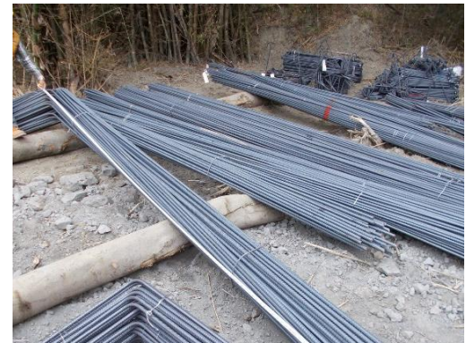
進場查驗 鋼筋取樣
