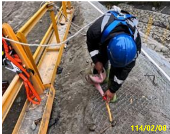
⑥ 灌漿錨筋澆置
