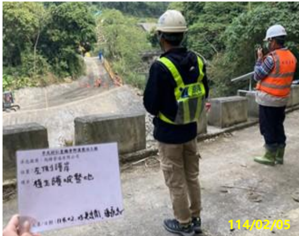
① 植生護坡坡面整理
