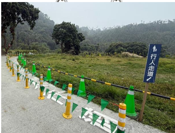
設置安全圍籬與動線指引
