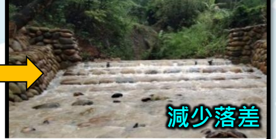
施作後(設置砌石護岸)
