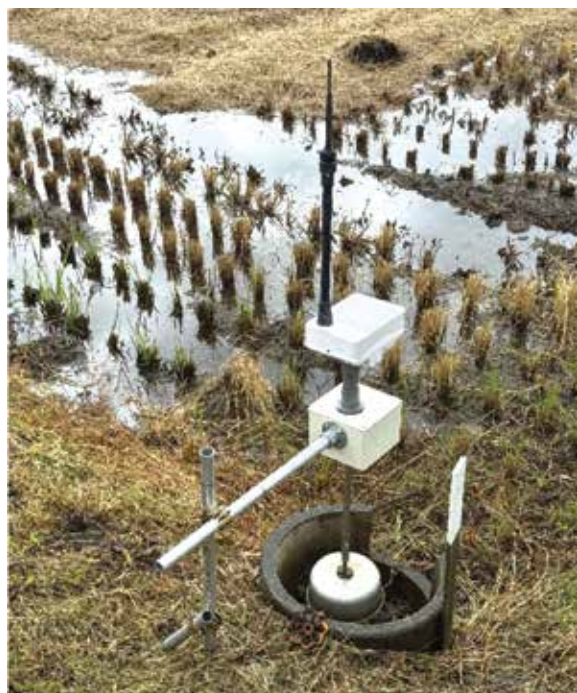
圖四、水稻田的自動供水閥，可以使用智慧型手機遠端控制灌溉水。
