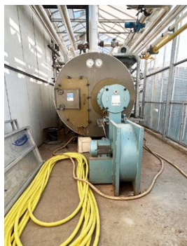
圖七、VD Burg專屬土壤消毒設備 (左)，由業者自己裝接管路 (右)，進行年度土壤蒸汽消毒
