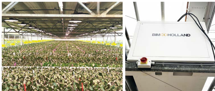
圖十、Cympha Orchideeën BV設施內採用全自動電照管理 (DLI) 模式（左）並在內部空間多點安裝除溼系統（右）
