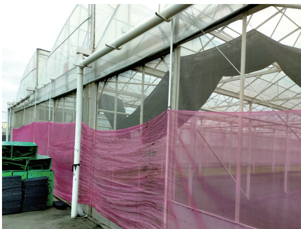
▲ 圖 4. 葉菜栽培溫室透過結構管材塗佈白漆，藉由反射太陽光進而改善設施內高溫蓄積問題。
