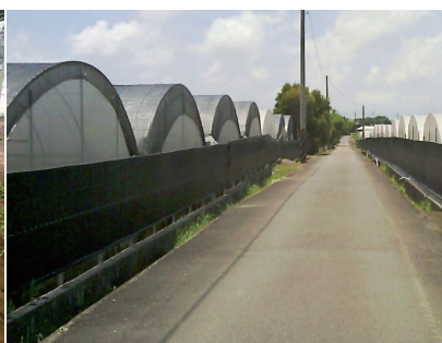
設施屋頂面遮蔭 (左)
