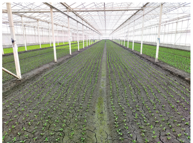
▲ 圖 4. 葉菜栽培溫室透過結構管材塗佈白漆，藉由反射太陽光進而改善設施內高溫蓄積問題。
