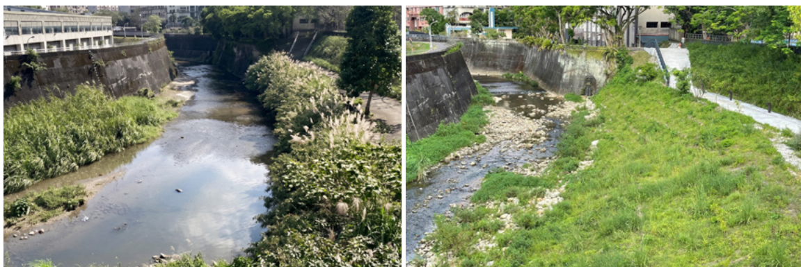
施作前的河道（左圖）寬而平，步道寬卻親水不易。改善後的河道（右圖）以卵礫石取代水泥作為河床底質及河道緣石，並加深河道、創造曲線，增加河相變化、復育河相多元性。
