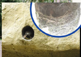
在塊石護岸的石頭上，預鑿孔洞以作為動物棲息之所。後來果真觀察到蛙類及鳥類在此棲息築巢，顯示該工法對生態有正面效果。
