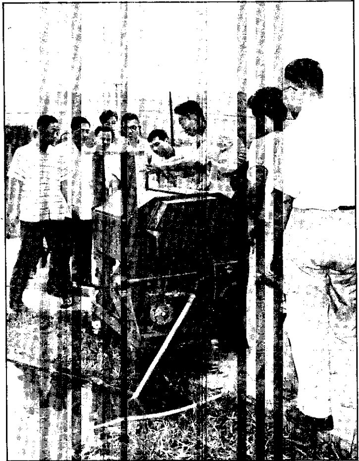
新式洗麻機： 根據古巴國的設計圖樣，農復會協助國立台灣大學農工系改進仿製完成，已在嘉義地區試用。這種新式洗麻機，每小時洗麻量達十三公斤以上。將來普遍推廣應用時，在剝製黃麻纖維的過程中，洗麻浸麻的時間與勞力，可望大為減低，並可提高纖維的品質。
