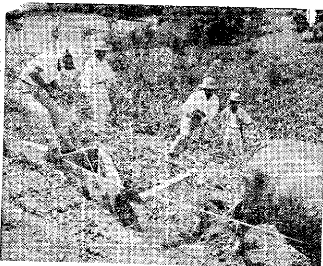
在陡坡上用三角拖板築平臺階段實況
