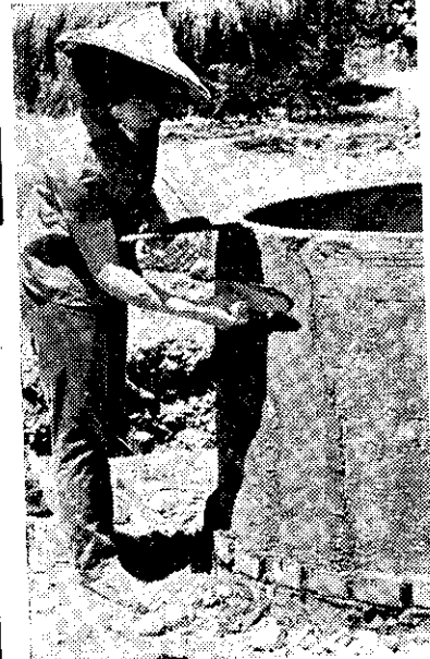
• 片 • 照 明 • 說 • (上) 用石頭砌造青貯窖情形 (中) 用磚砌造後內外抹水泥 (下) 做好青貯料後覆蓋防雨
