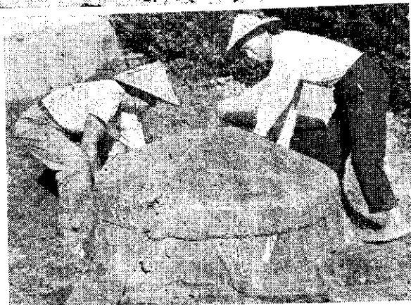
● 片 ● 照 明 ● 說 ● (上) 用石頭砌造青貯窖情形 (中) 用磚砌造後內外抹水泥 (下) 做好青貯料後覆蓋防雨
