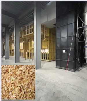
▲ 粗糠爐以稻殼為燃料，替代化石燃料或電力，達到減碳效果
