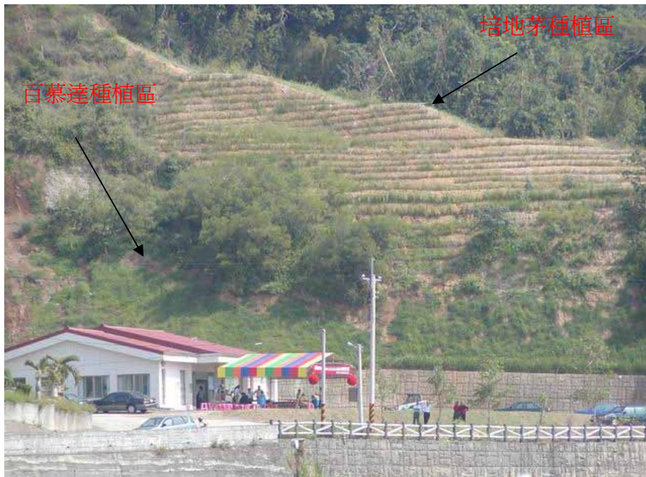
畜產試驗所新竹分所西湖場之水土保持護坡工程實作。 攝於九十四年十月二十五日
