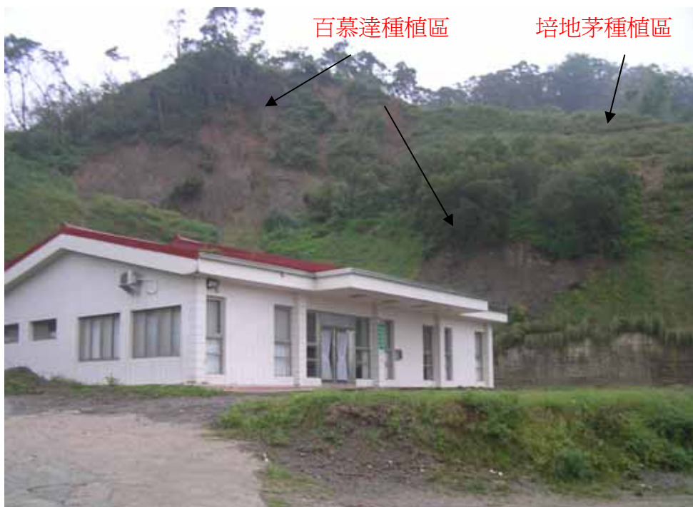
畜產試驗所新竹分所西湖場之水土保持護坡工程實作。 攝於九十五年四月十四日
