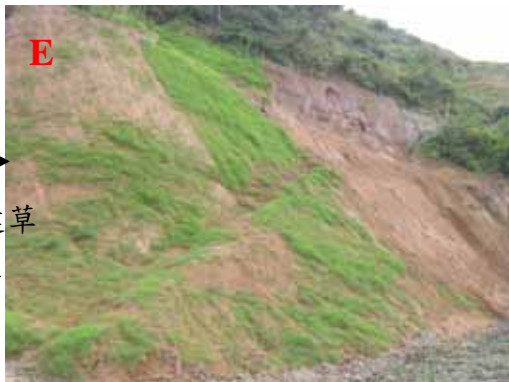
圖 3. 培地茅於山坡地實際施作護坡情形
