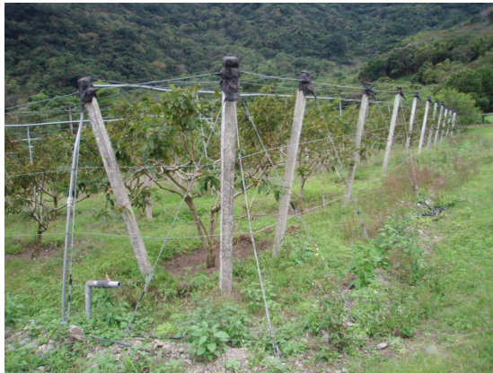
圖 1. 簡易網室支架四周及內部之 3.64 公尺水泥柱。
