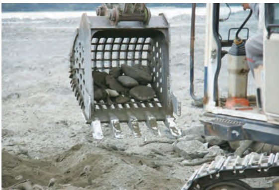
圖 3. 利用挖土機篩除石塊及雜物
