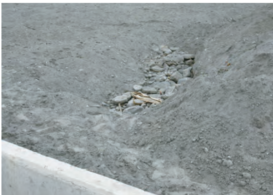
圖 2. 復建後之土壤，宜清除土層 1 公尺深度內之 大石塊及雜木。
