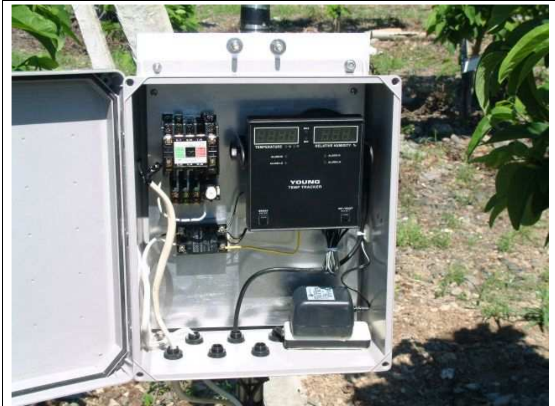
圖 15. 利用溫、濕度感測元件自動感應啓動撒水灌溉設施
