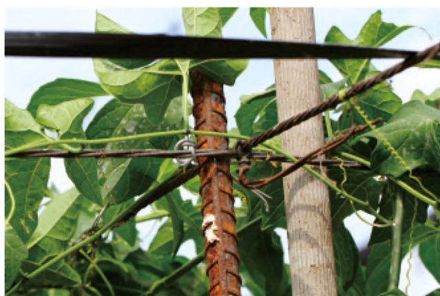
圖4. 田區無水泥柱可供植株攀附生長處，可立鋼筋支撐棚架兼作植株攀附用柱。
