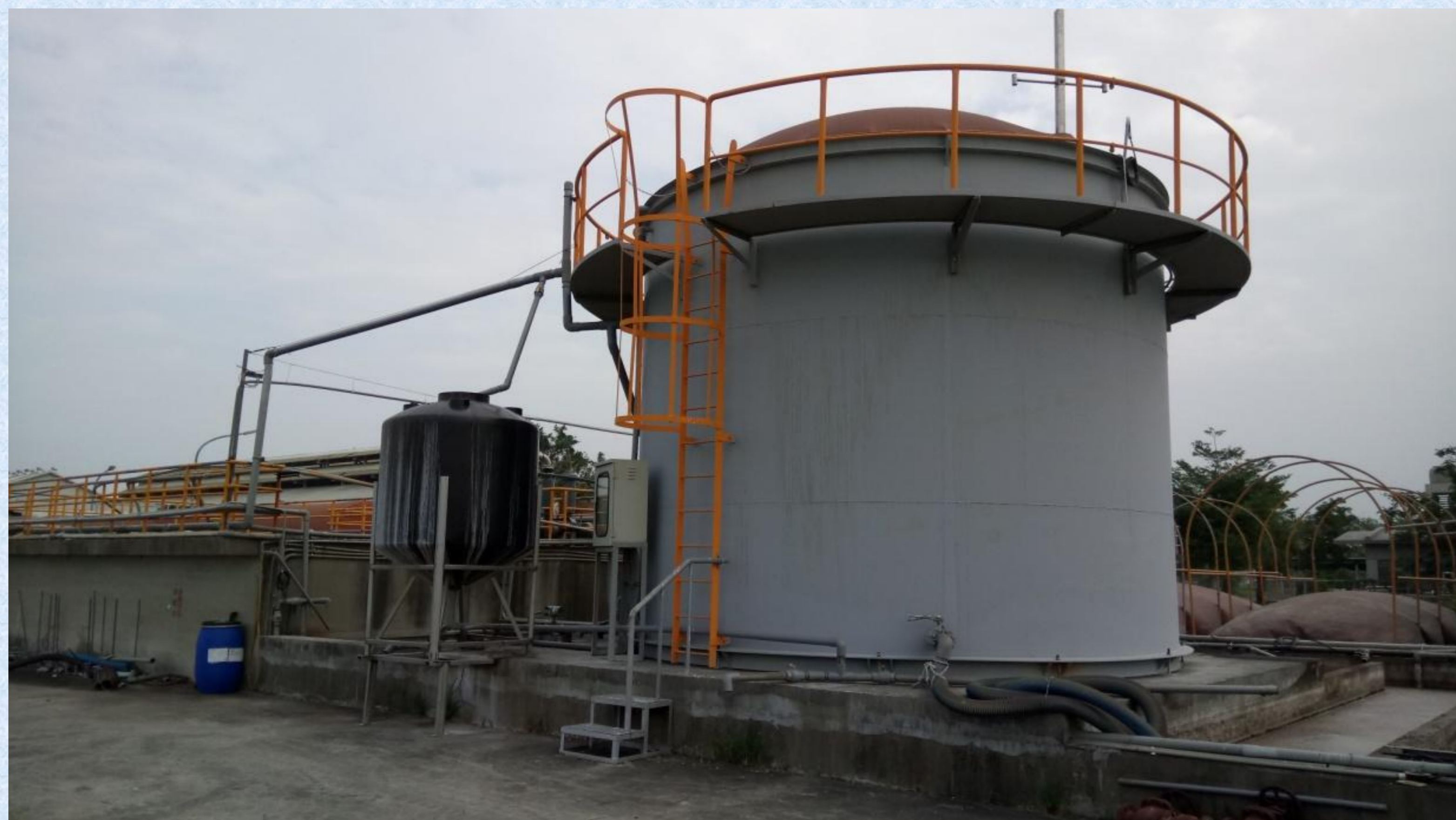
直立式發酵槽保溫加熱裝置安裝前
