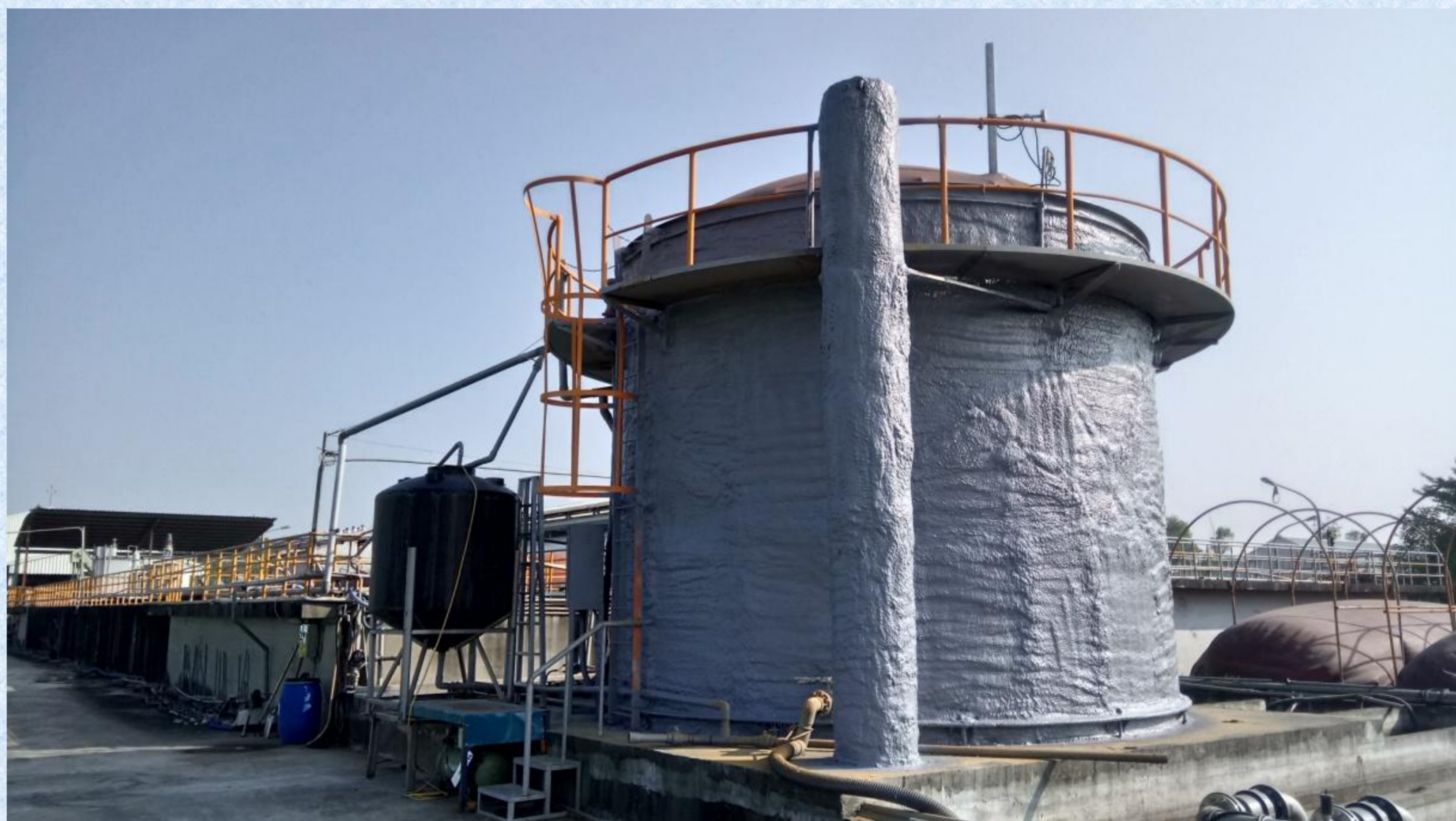
直立式發酵槽保溫加熱裝置安裝後
