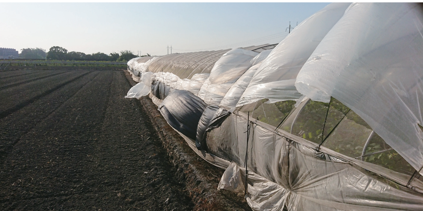
⊗ 溫室設施固定不良與使用年限過久，容易遭遇強風吹襲而脫落
