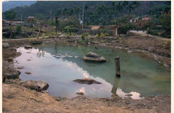
剛完工之生態池
