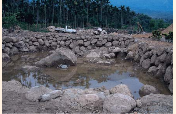
剛完工之生態池
