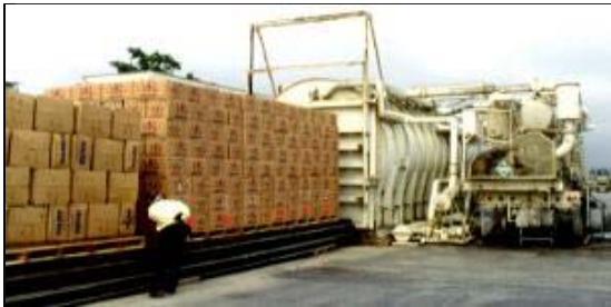
大型真空預冷機操作情形
