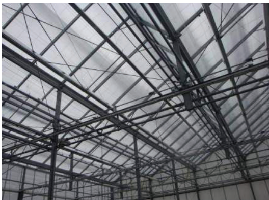
圖 17. Daylight 節能溫室聚光板屋頂結構
